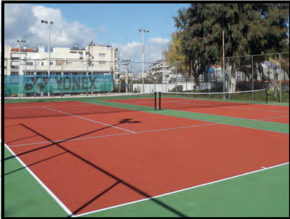
2.Ακρυλικός τάπητας CUSHION σε ασφαλτική επιφάνεια
